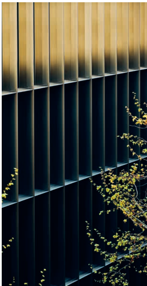
Die Lamellen der vorgehängten Fassade haben eine Tiefe von rund 30 Zentimetern.
