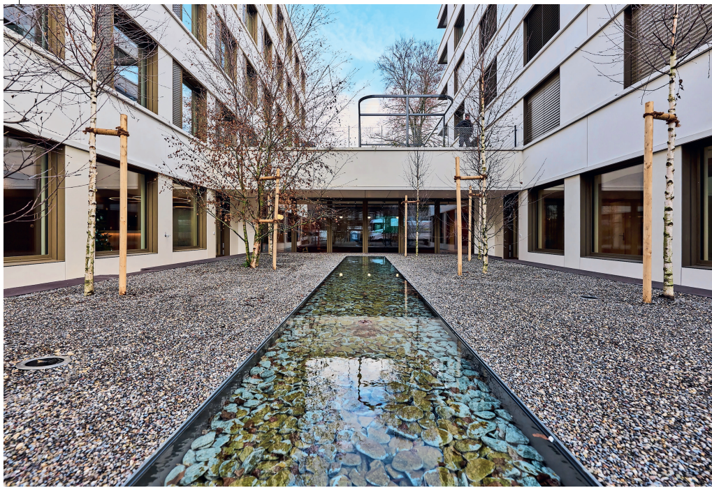
Die Filiale im Erdgeschoss verbindet die beiden Gebäude. Die durchgehende Fensterfront öffnet den Blick in den Innenhof und auf die gegenüberliegende Seite der Filiale.
