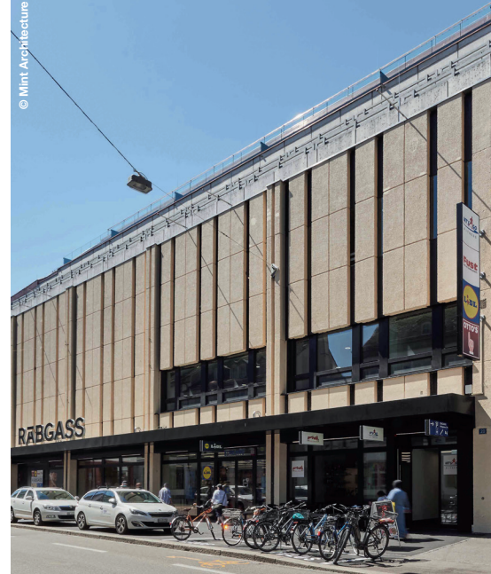
Neues Gesamtbild: sanierte Fassade aus Waschbeton aus den 80er-Jahren.
